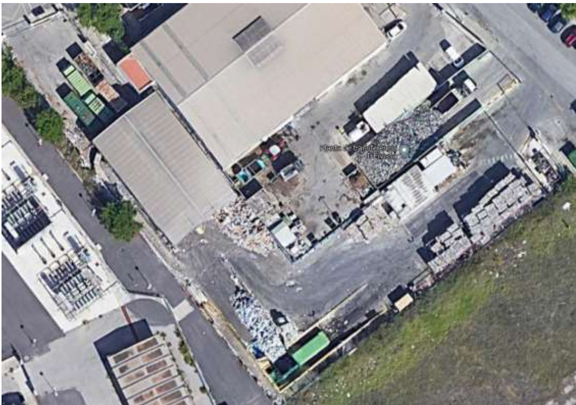
Ilustración 16. Vista aérea de la actual planta de transferencia
