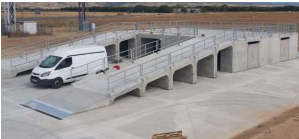
Ilustración 21. Instalación de un punto de vertido prefabricado con rampas para el vertido
