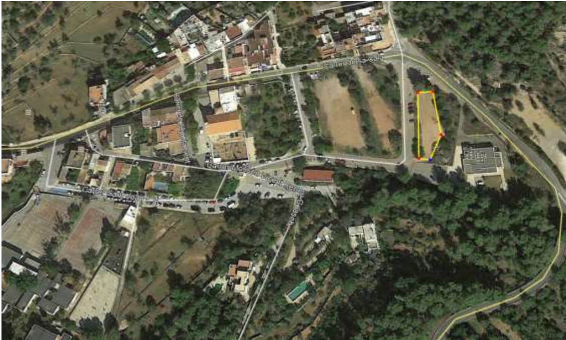
Ilustración 18. Propuesta de ubicación para un nuevo punto limpio en San Juan Bautista
